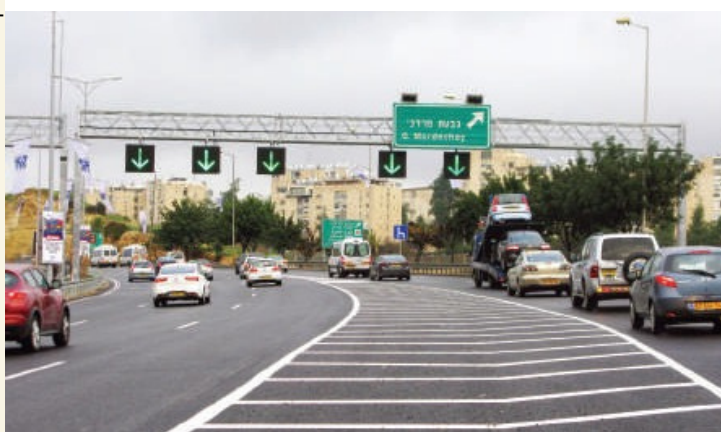
Входът на тунела Begin, Йерусалим, Израел, 2012 г.
