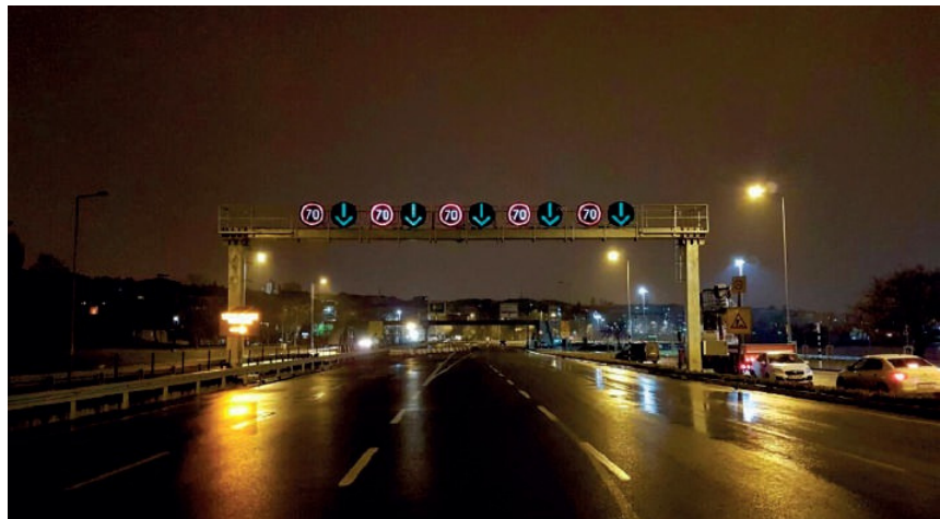
Входът на тунел Евразия в Истанбул, Турция, 2016 г.
