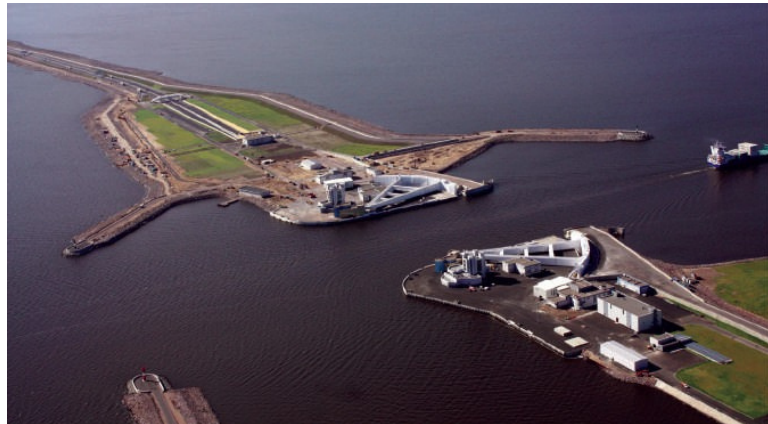
Входът на Морския тунел в Санкт Петербург, VMS - VTS, Русия, 2011 г.
